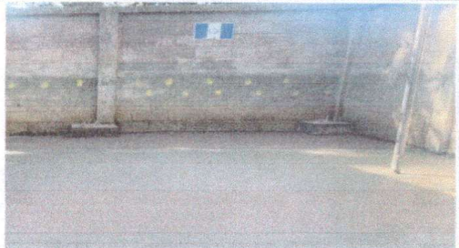
Foto 2: Reparación de piso de torta de concreto, en patio
