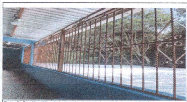
Foto 5: Sustitución de baranda de metal, pasillo segundo nivel
