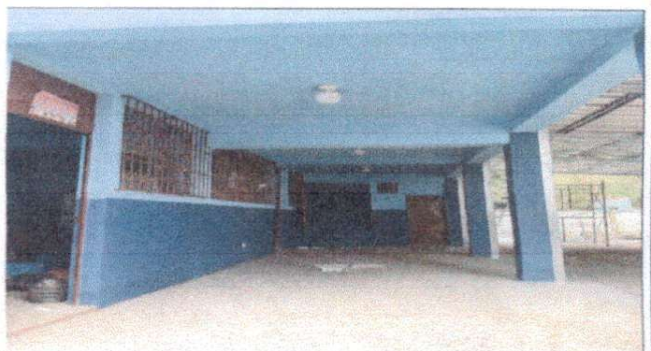
Foto 4: Pintura en muros interiores y pasillos del establecimiento
